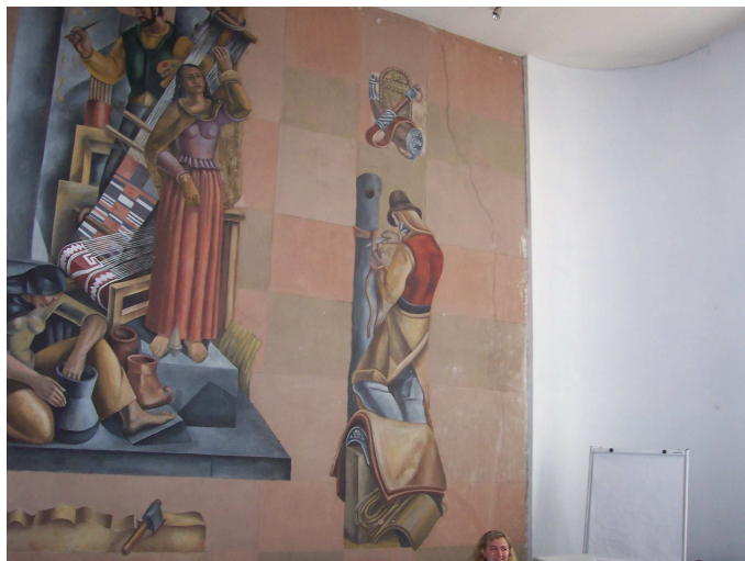
Fig. 18 - Fisuras en muro izq. desde el interior de “Coordinación”
