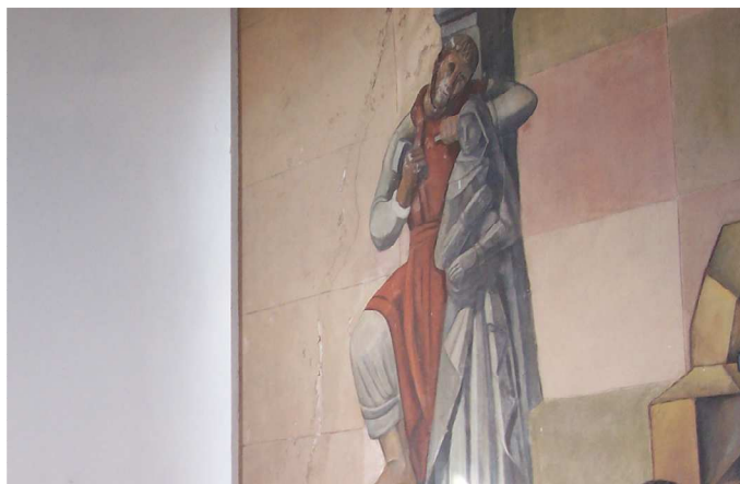
Fig. 19- Fisuras en muro derecho desde el interior de “Coordinación”
